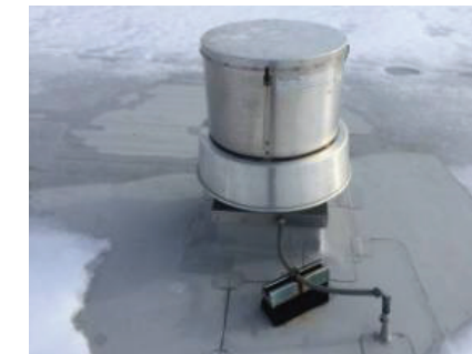
Exhaust Air Fan
