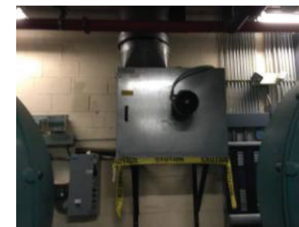
Combustion Air Fan
