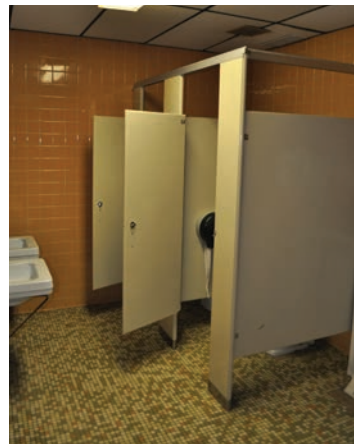
Inaccessible Toilet Stalls
