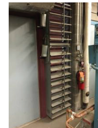
Combustion Air Louver
