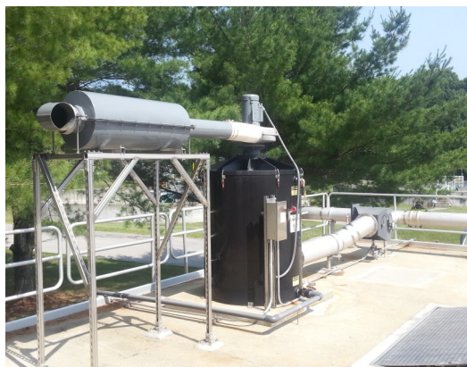
New Calgon (odor) unit at WWTP
